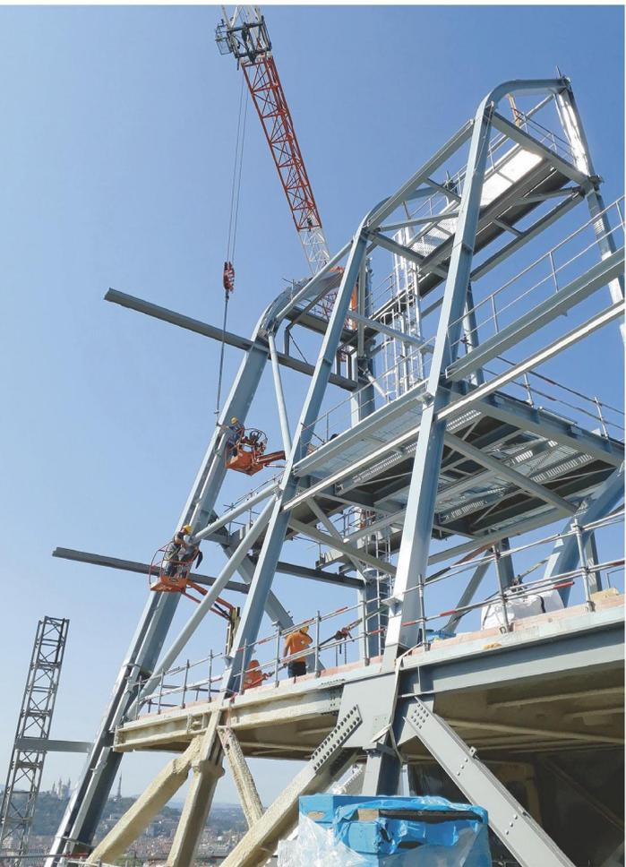
La coiffe de la tour métallique est en cours de pose grâce à une grue installée sur la toiture de la tour de béton
