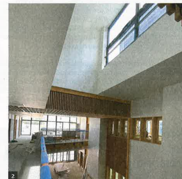
1 - Le système de rues intérieures repose sur une ventilation et une lumière naturelles. 2 - Chaque rue se compose d'un jeu de passerelles et de trémies, surmontées de sheds.
