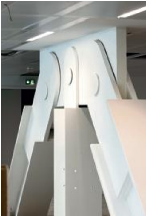
Le squelette de métal du bâtiment traverse les espaces de travail.
