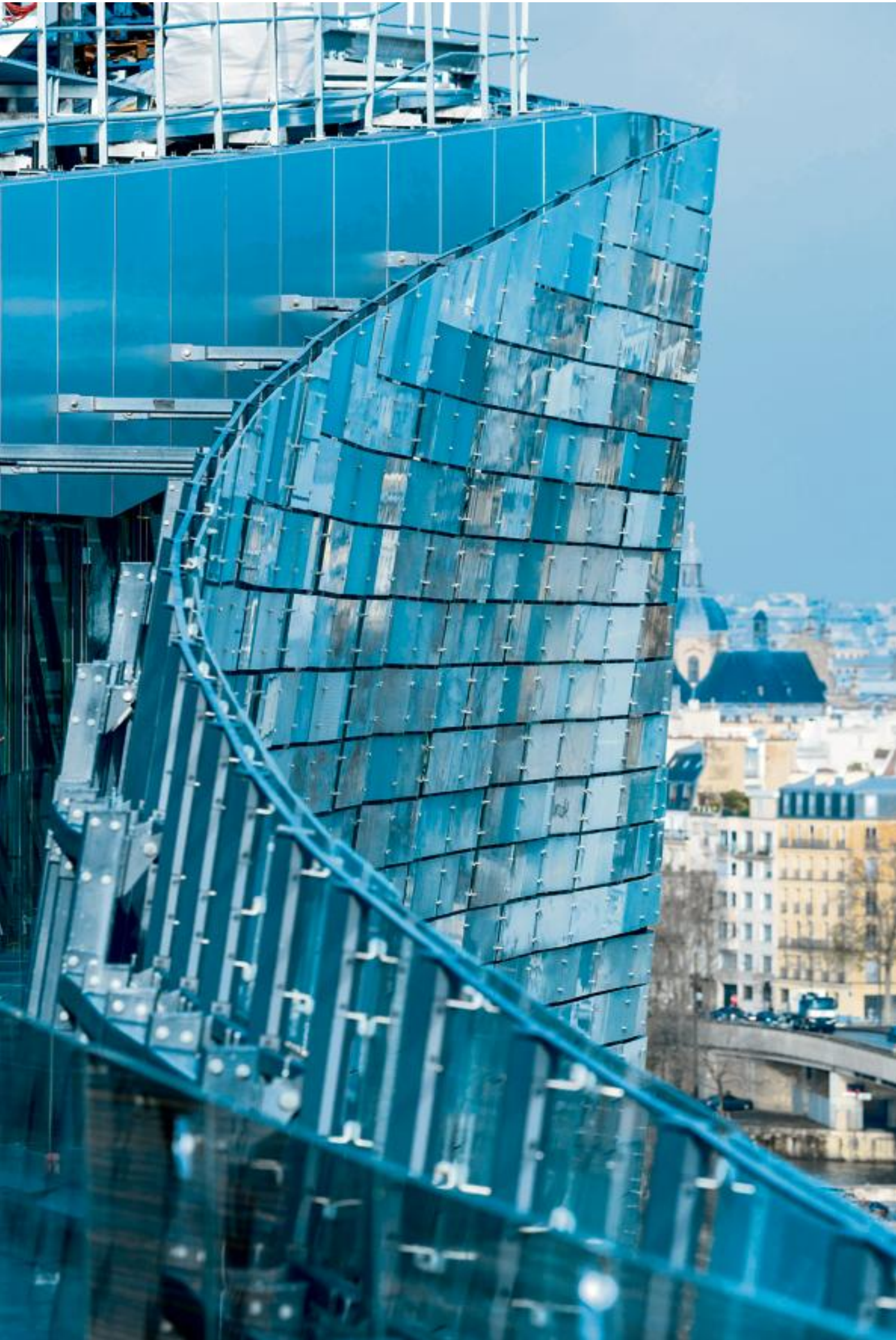
L'originalité du projet réside également dans sa façade : une « deuxième peau », composée d'environ 20 000 panneaux de verre avec différents degrés de transparence. PHOTOS : LAURENT THION/ECLIPTIQUE POUR « LE MONDE »
