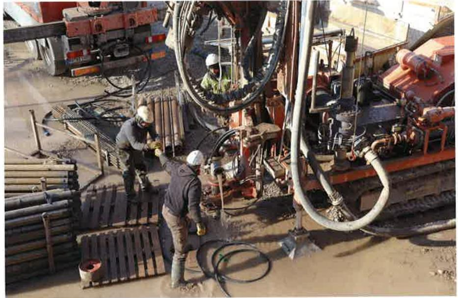
**Deux équipes de trois personnes sont réquisitionnées pour la réalisation et le raccordement des sondes géothermiques verticales.**
