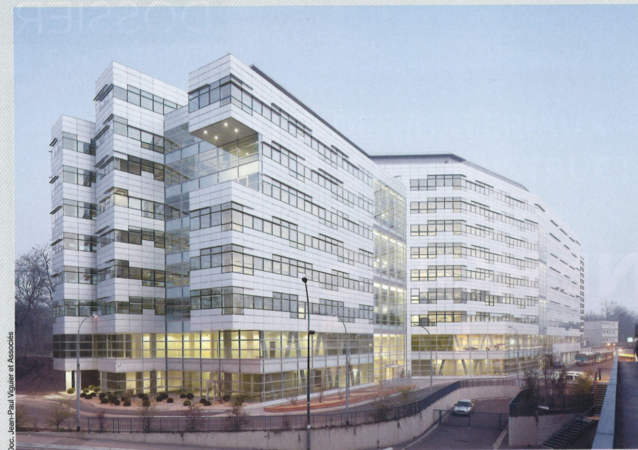
À Joinville-le-Pont (Val-de-Marne), l'immeuble Urbagreen (19 000 m 2 Shon), livré début 2014, accueille le nouveau siège de la Bred. Pour ce projet sont installés 75 m 2 de tubes sous vide assurant le préchauffage de l'eau chaude sanitaire du restaurant interentreprises.
